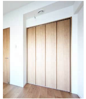
居室天井に脱臭機を設置
