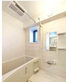
浴室暖房乾燥機の新設をはじめ バスルームをまるごと入れ替え
